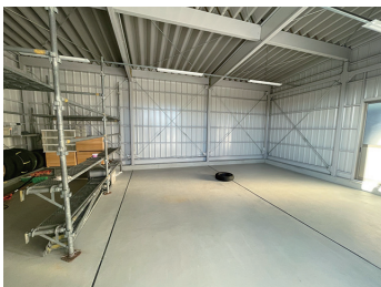
エリア拡大に伴い建設した新聞仕分け作業を行う作業場兼倉庫
